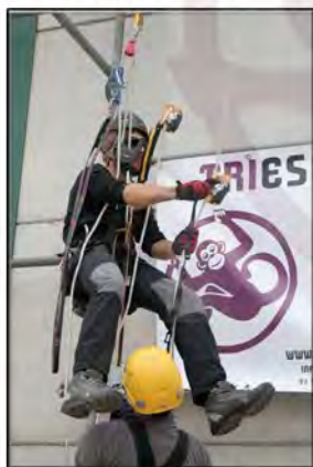
3.- Desbloqueo de anticaidas
