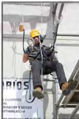
3.- Desanclaje de la estructura
