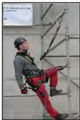
Posicionamiento en anillas laterales
