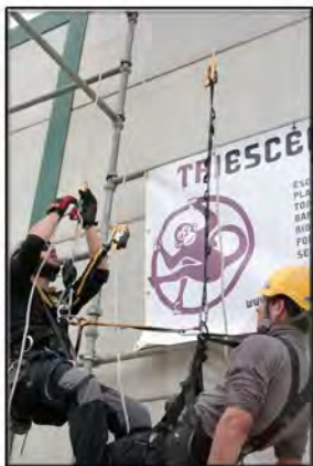
1.- Montaje de polipasto
